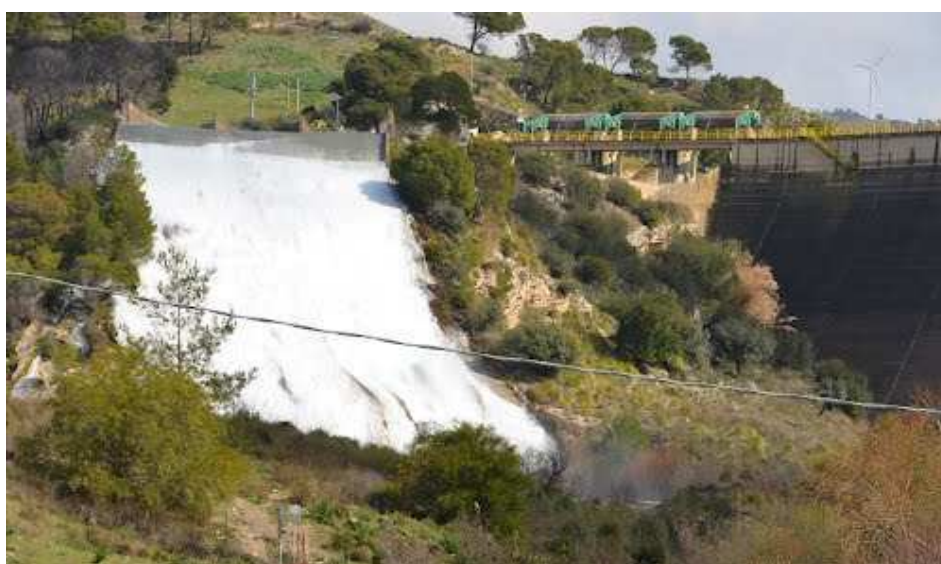
Figura 3.2 – Scarico di superficie
