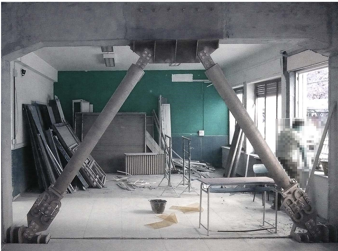
Installazione di controventi dissipativi
